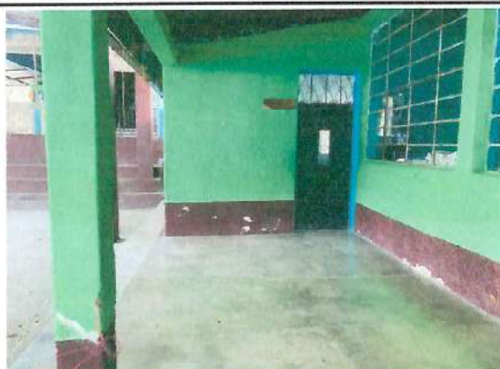
Foto 3: Cambio de piso de cemento a piso creamico o granito de las 3 aulas del modulo y corredor.
