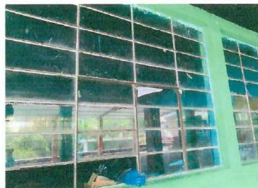
Foto 2: Cambio de ventas y Balcones de 3 aulas del modulo.
