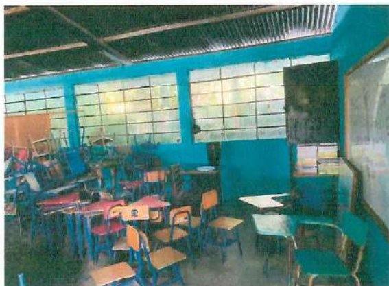
Foto1: Cubierta de lamina calibre 26 troquelada y reparacion de estructura metalica de 3 aulas.
